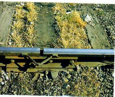
**Detalle de una junta de dilatación en una vía de tren.** Los orificios de la placa que une los dos tramos de vía no son redondos, sino que tienen una pequeña holgura que permite el desplazamiento relativo del riel.
