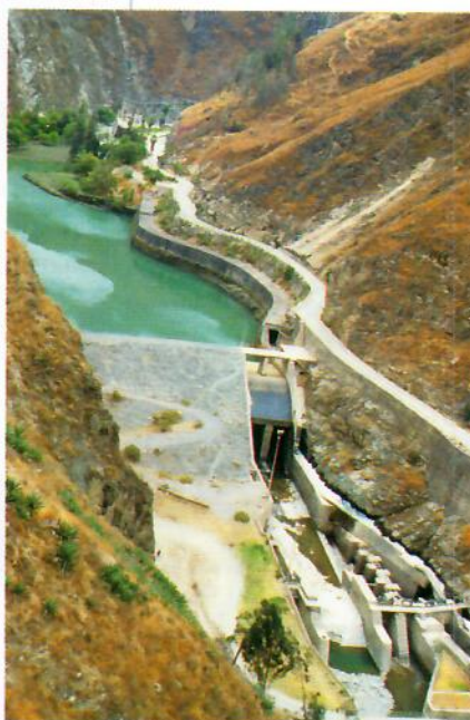
Central Hidroeléctrica de Huinco, Lima
